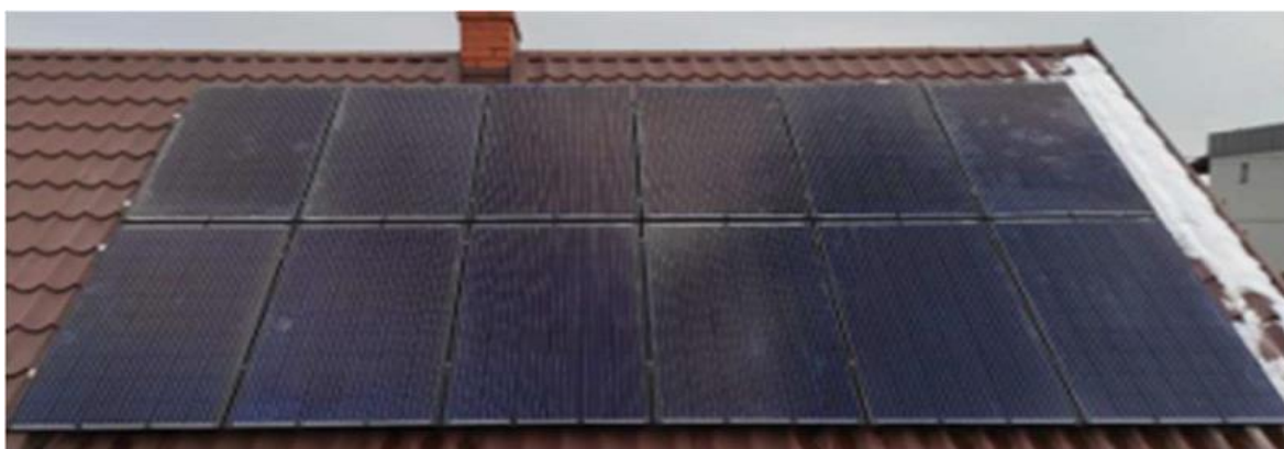
Abb. 3 An einem bewölkten Tag aufgenommene Fotografien. Optische Unterschiede aufgrund von Schmutz und Feuchtigkeit.
