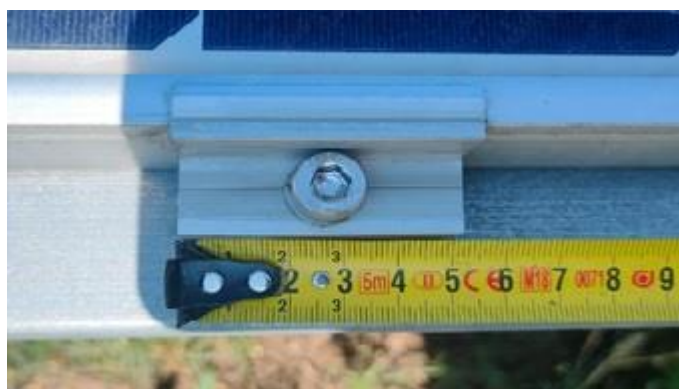
Abb.5 Abmessungen der Befestigungsschelle
